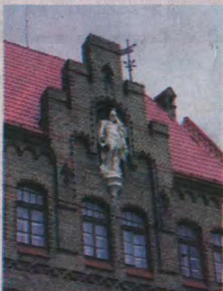
Львов. Кованые элементы на центральном фасаде старейшей в городе пожарной части здания, в котором располагается львовская пожарная охрана.
