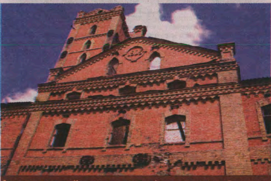
Старокопстантинов. Кованые элементы на фасаде здания старой мельницы.
