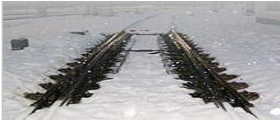
Рис. 2.3. Система електрообігріву стрілочних переводів
