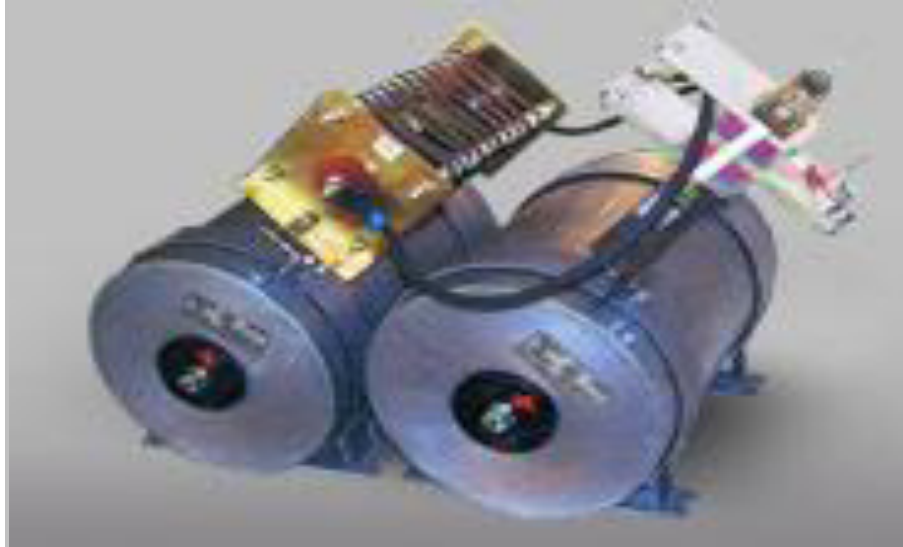
Рис. 2.2. Конденсаторні системи пуску КСП
